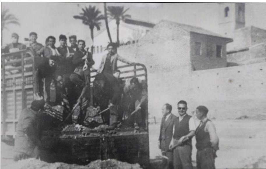
Descarregant un camió de material de construcció. Mon pare Vicent sembla que és el primer per l'esquerra, damunt del vehicle, al costat de la palmereta
