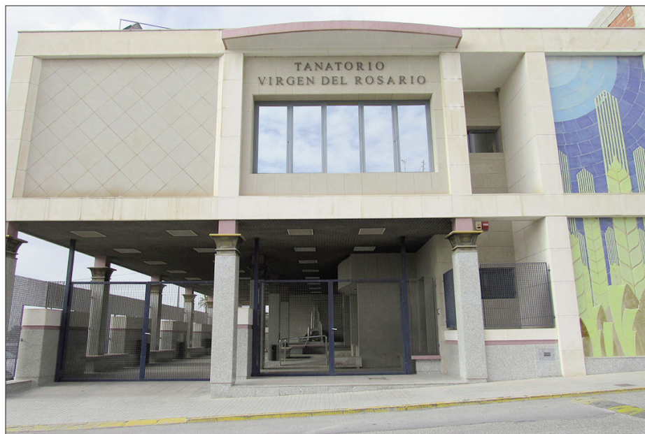
Fachada principal del Tanatorio Virgen del Rosario, propiedad de la Cooperativa Eléctrica
