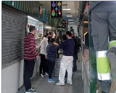
Instalación de los elementos decorativos
